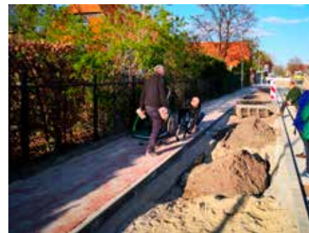
Überprüfung der Gehwegbreite
